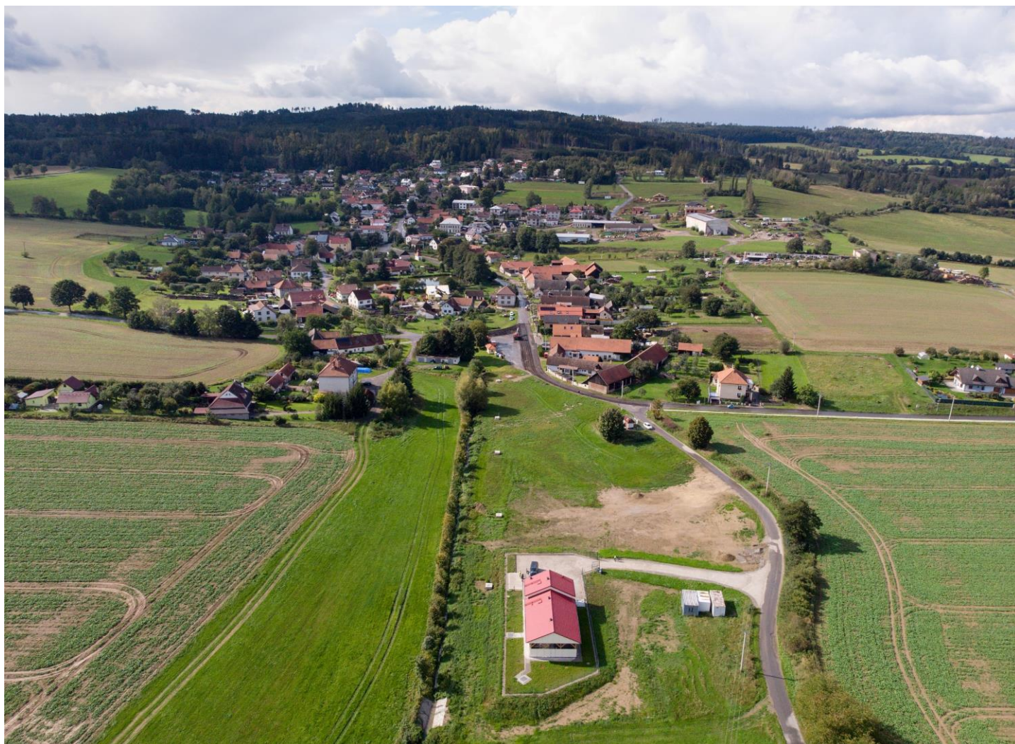
Cejle pohledem od ČOV na opravovanou křižovatku
